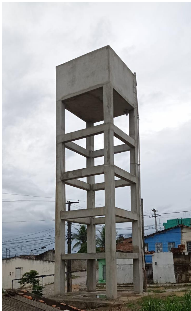
Figura 18 – Reservatório elevado recuperado
