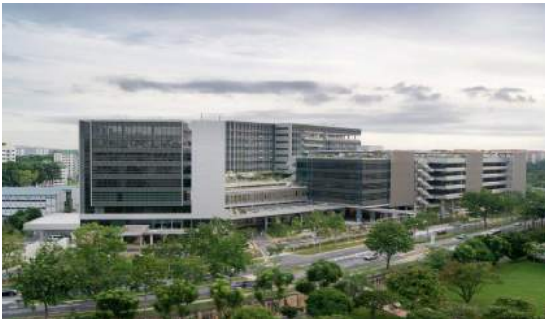
Figura 15: Vista panorâmica externa do Khoo Teck Puat Hospital
