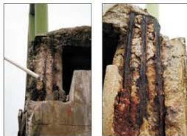
Figura 15 - Corrosão uniforme.
