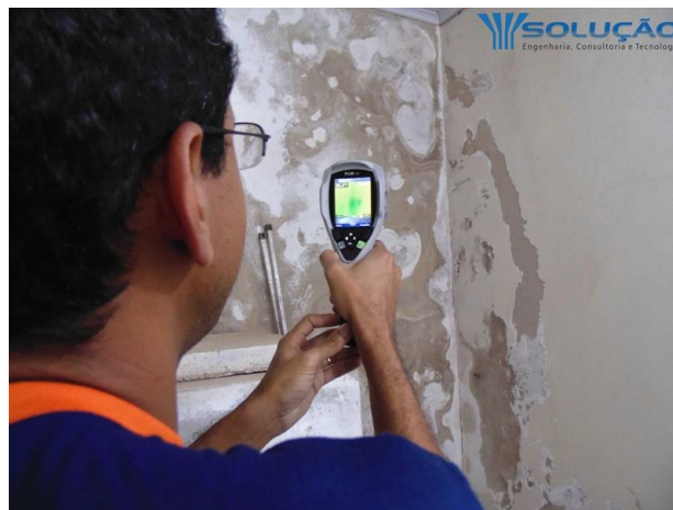
Figura 13- Ensaio de termografia infravermelha.
