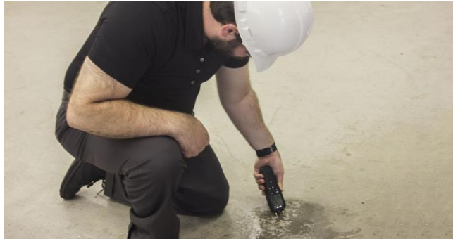
Figura 8- Ensaios não destrutivos por meio de medidor de umidade.
