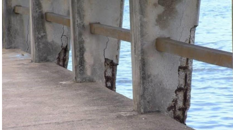
Figura 19 - Representação da corrosão de íons cloreto.
