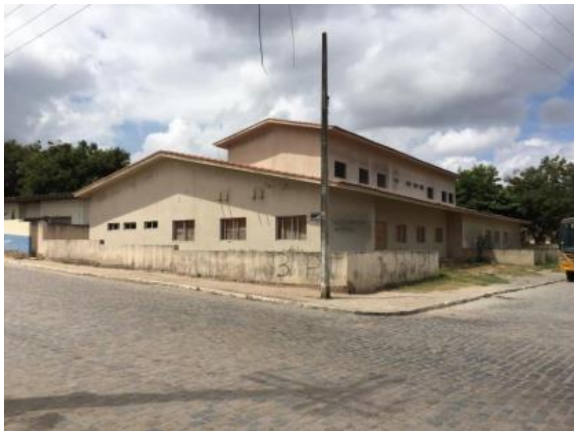
Figura 20 – Fachada frontal – UPA
