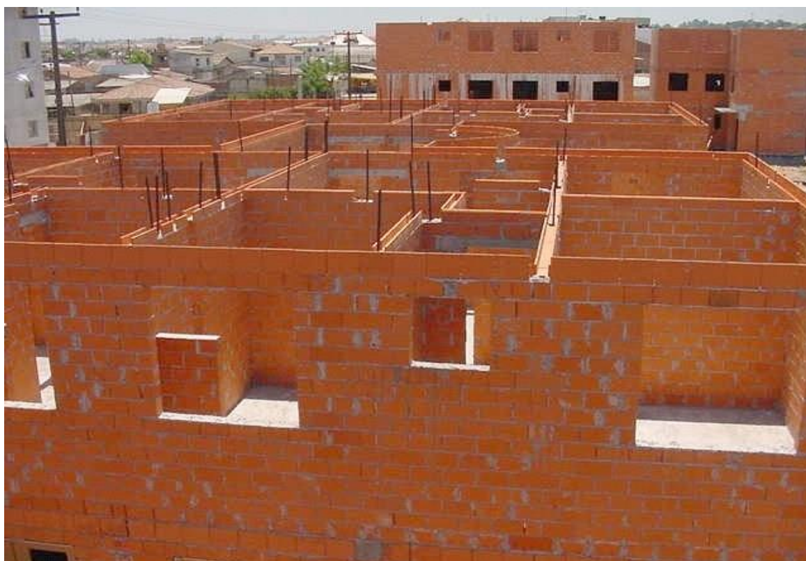
Figura 17 – Construção de alvenaria estrutural.
