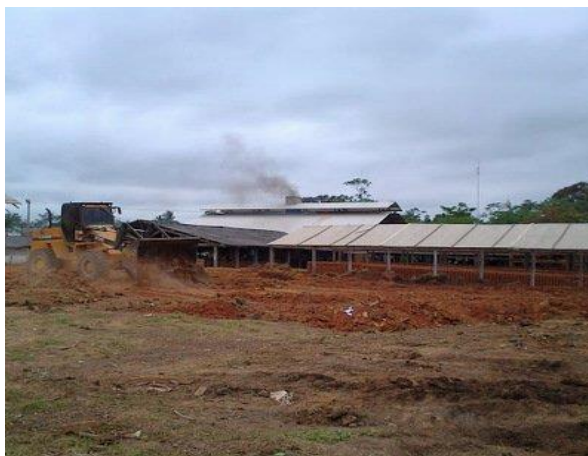
Figura 9 – Galpão de secagem.
