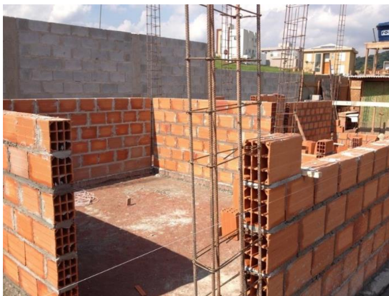
Figura 22 – Alvenaria convencional de vedação.
