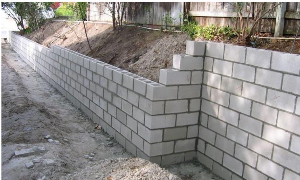
Figura 25 – Construção com blocos de concreto de vedação.
