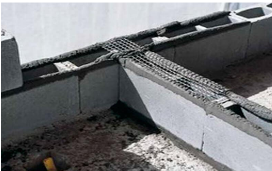
Figura 26 – Construção com blocos de concreto de vedação, estrutura com amarração.
