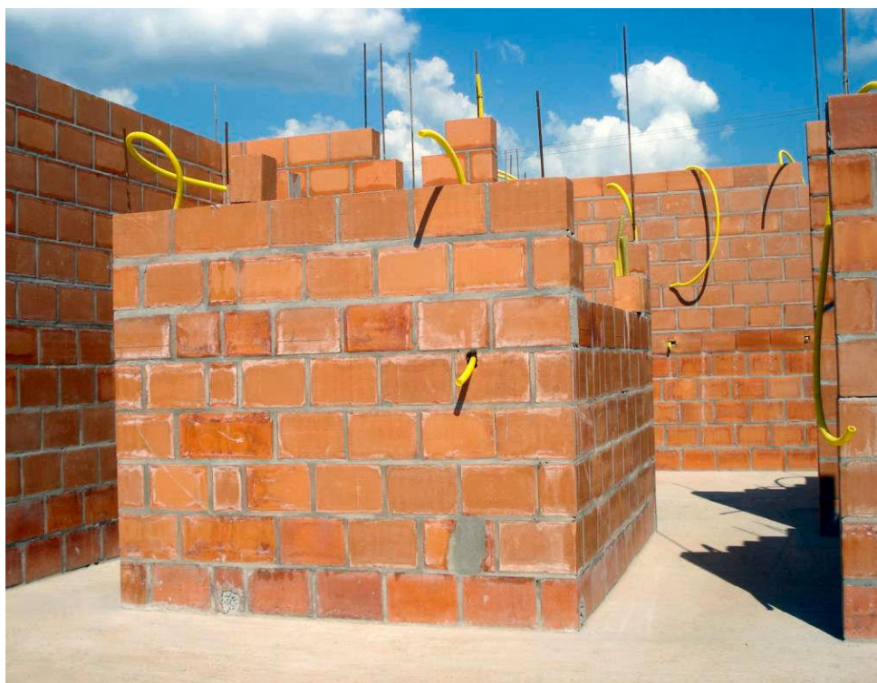
Figura 16 – Paredes de sustentação blocos cerâmicos.
