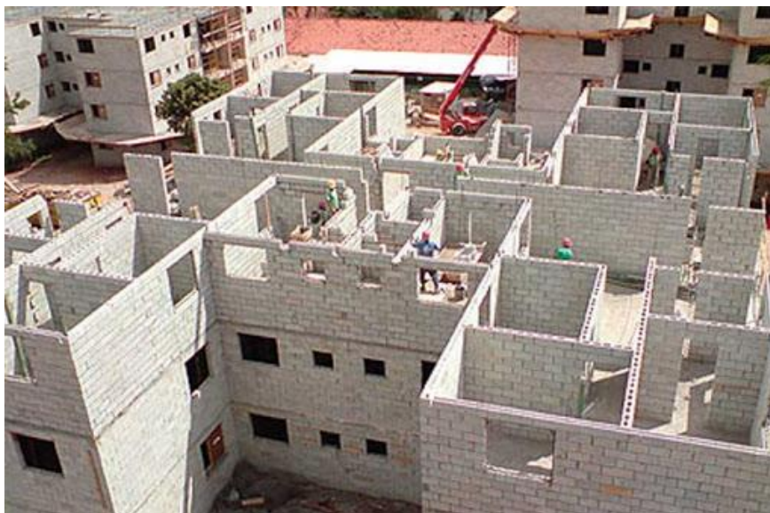
Figura 27 – Construção com bloco de concreto estrutural.
