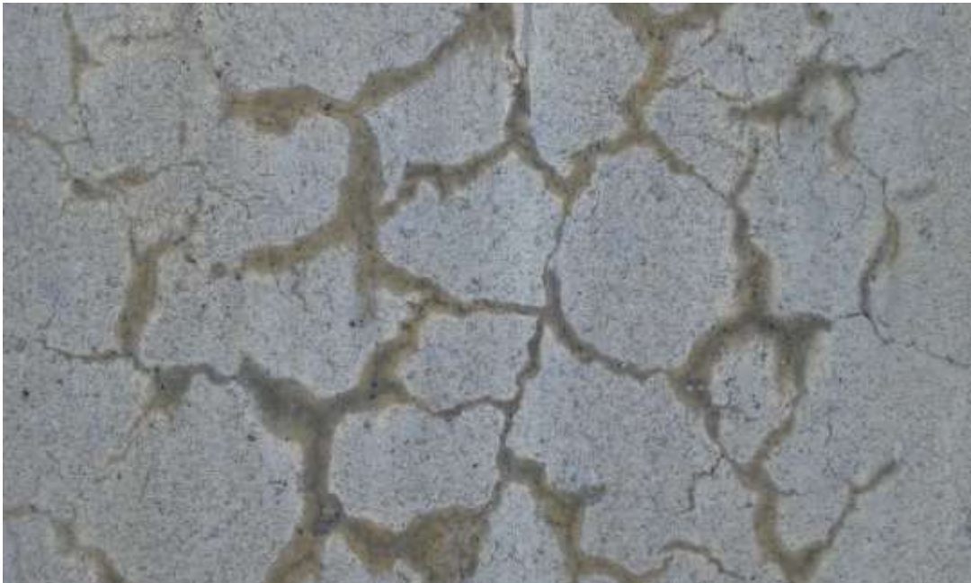
Figura 5: Reação álcali-agregado.
