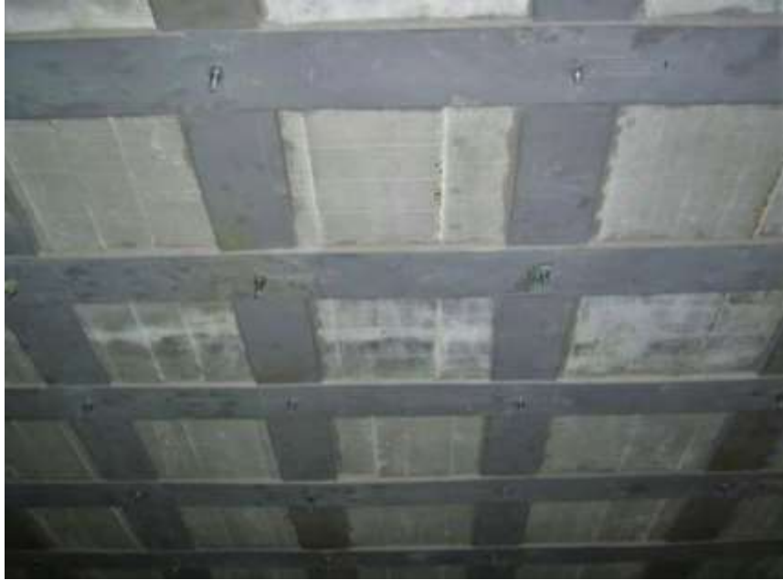
Figura 15: Reforço de laje com chapas metálicas com adesivo e parabolts.
