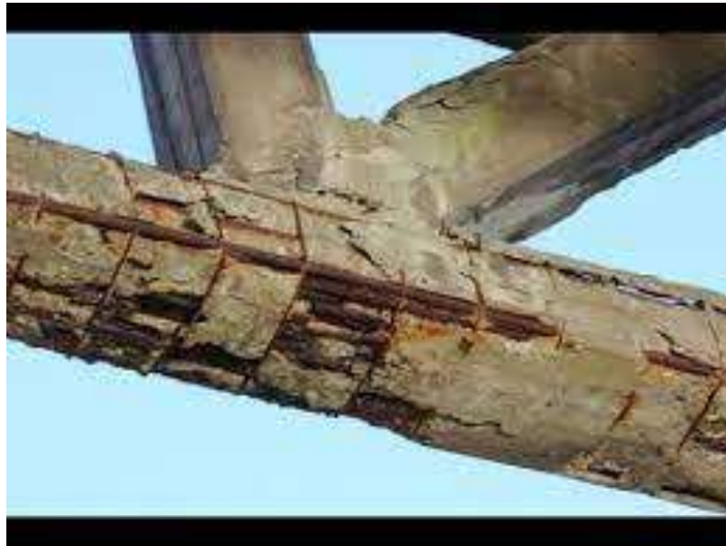
Figura 6: Carbonatação.
