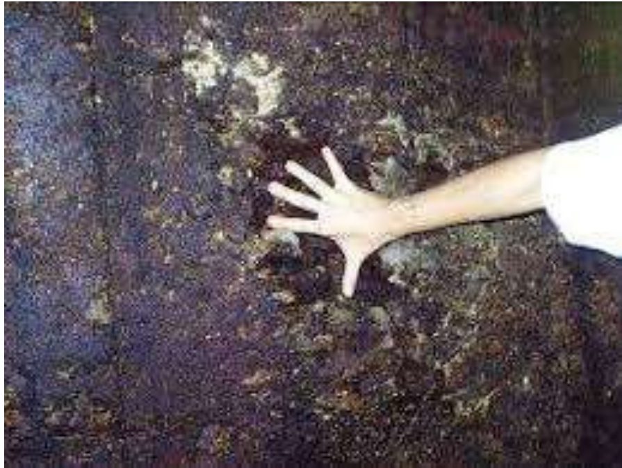
Figura 3: Desgaste por abrasão.
