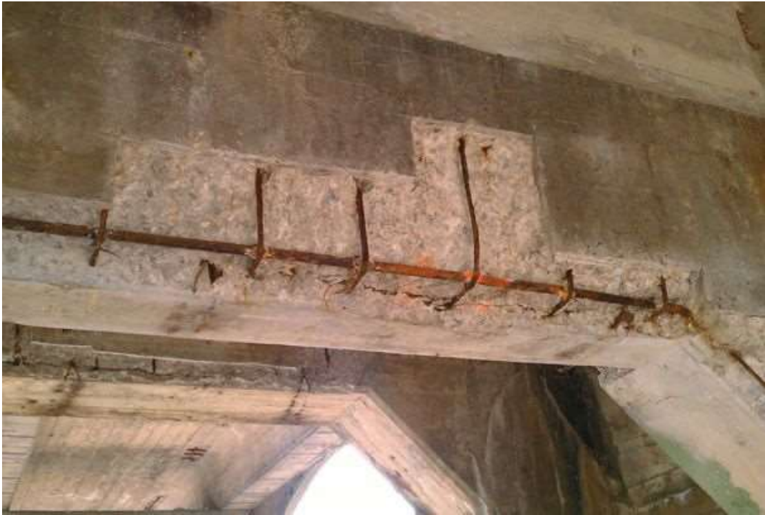
Figura 1: degradação por Tensões térmicas
