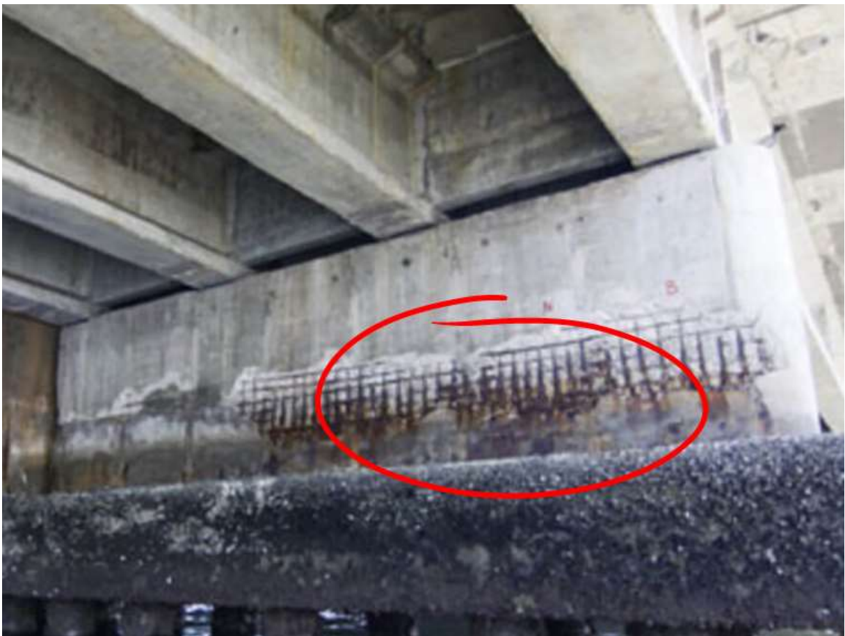
Figura 4: Ataque de sulfatos.
