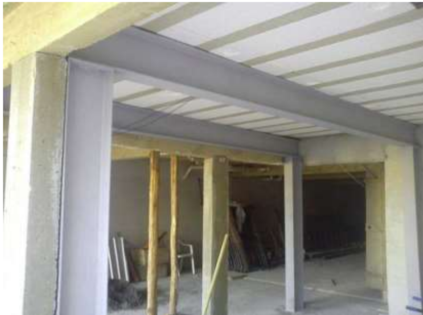
Figura 16: Reforço com perfis metálicos.
