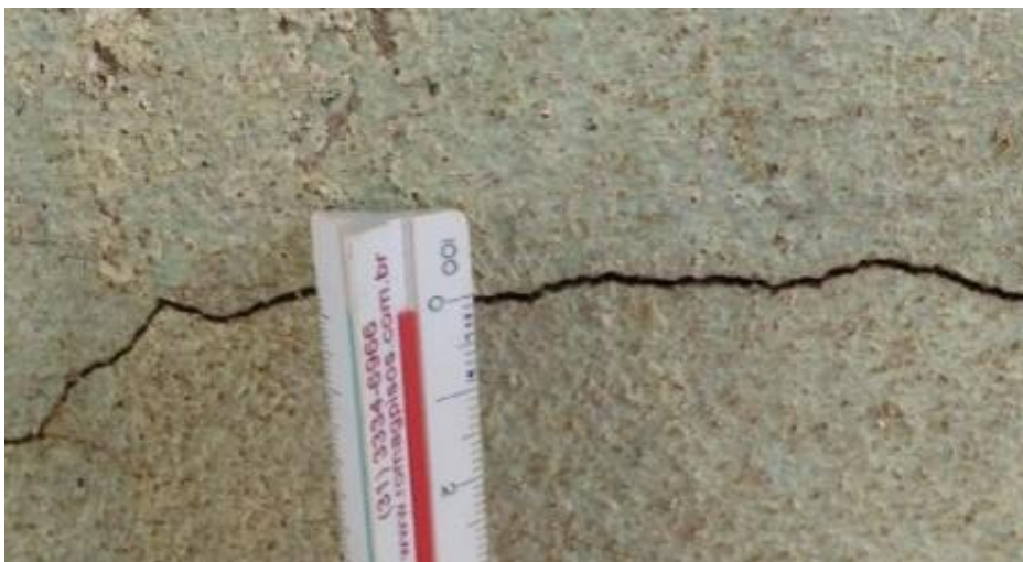
FIGURA 4 – Trinca.
