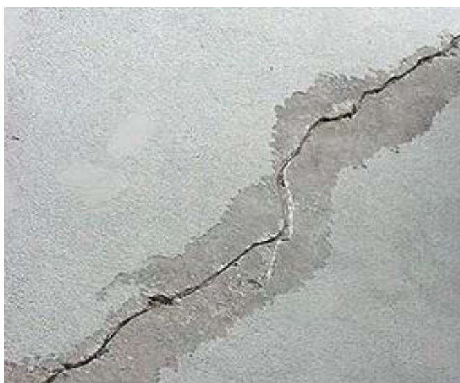
FIGURA 2 – Fissura geométrica.
