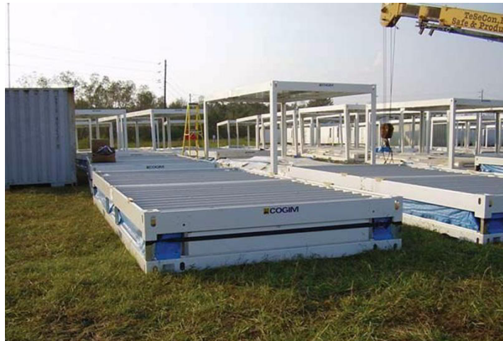
Figura 08 – Abrigo desenvolvido pelo exército americano, chamado COGIM
