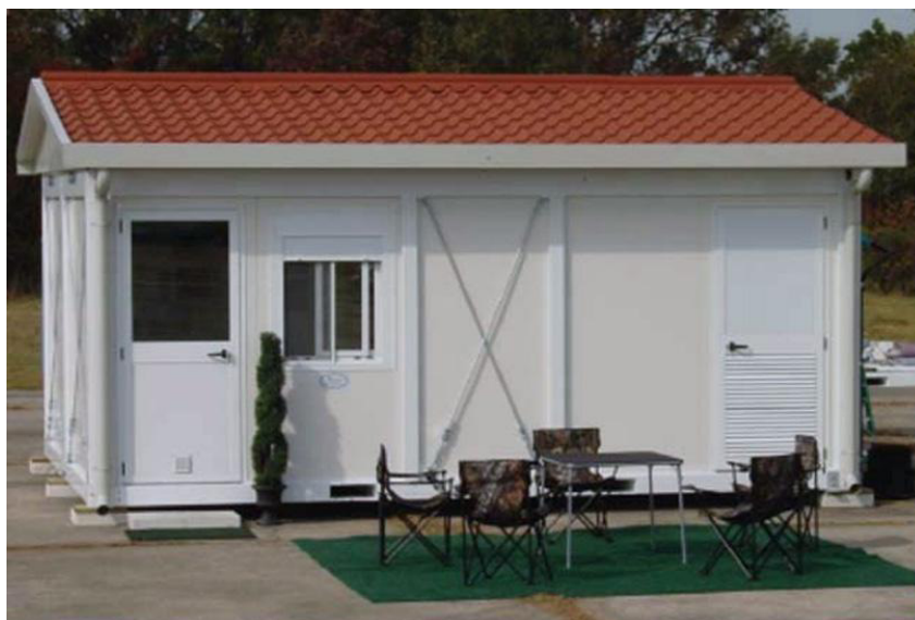
Figura 10 – Abrigo COGIM montado como módulo independente
