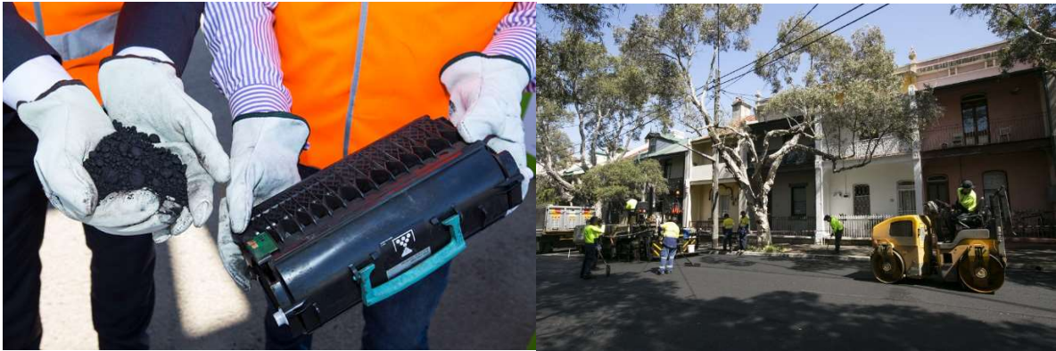
Figura18: Pavimentação com TonerPave
