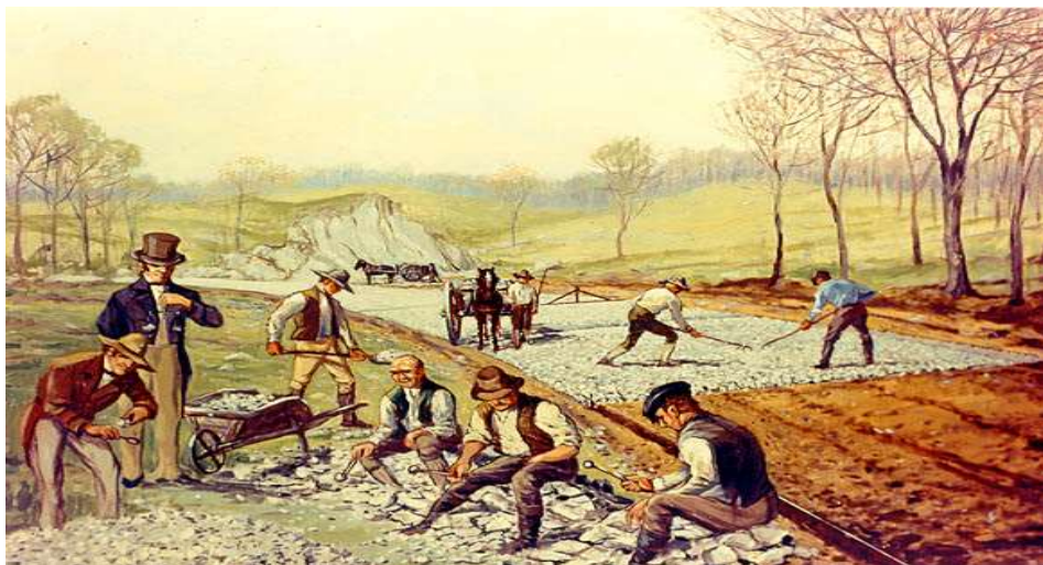
Figura 5: Construção da estrada em macadame.
