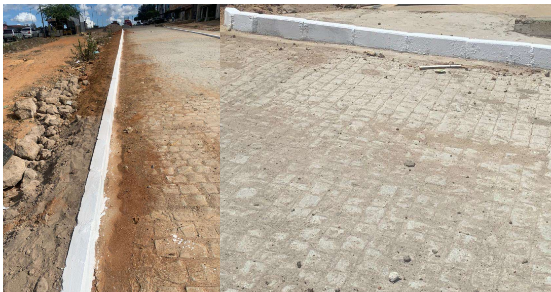
Figura 32: Pintura do Meio-fio e espelho.
