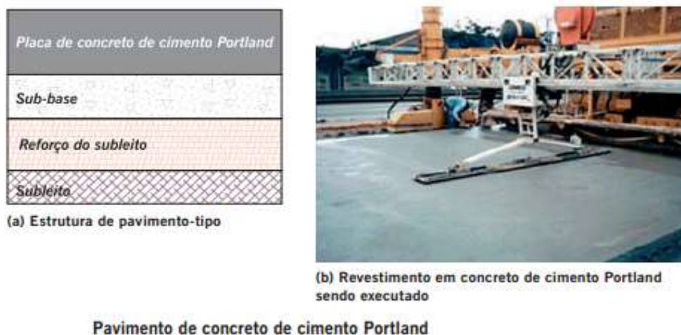
Figura 12: Pavimento de Concreto de Cimento Portland
