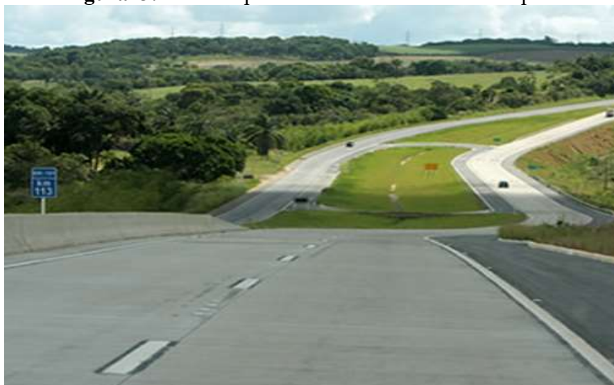
Figura13: Rodovia pavimentada com concreto simples.
