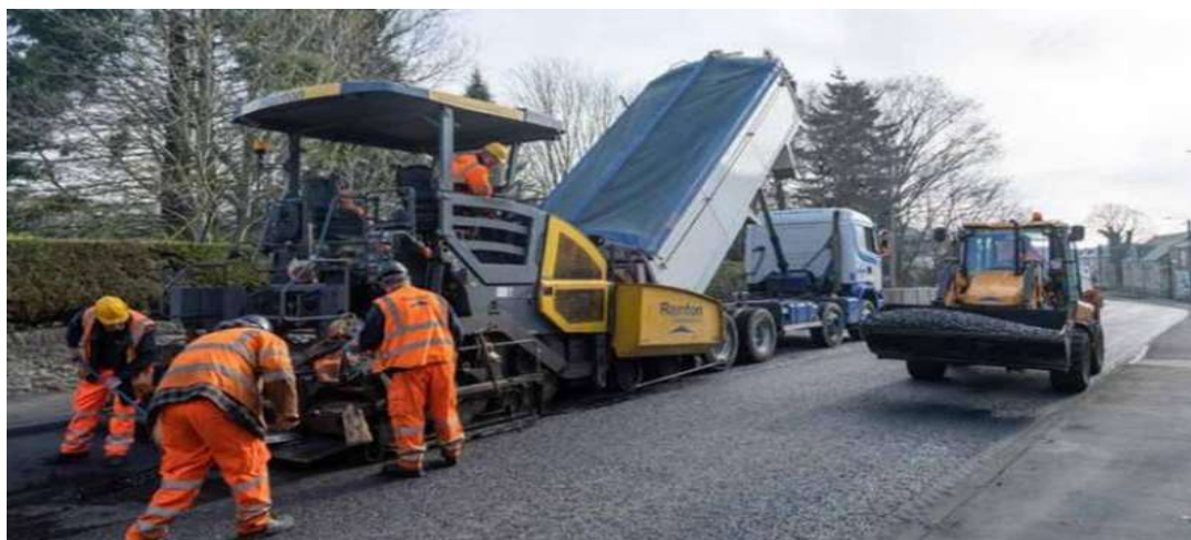
Figura 17: Pavimentação com plásticos.
