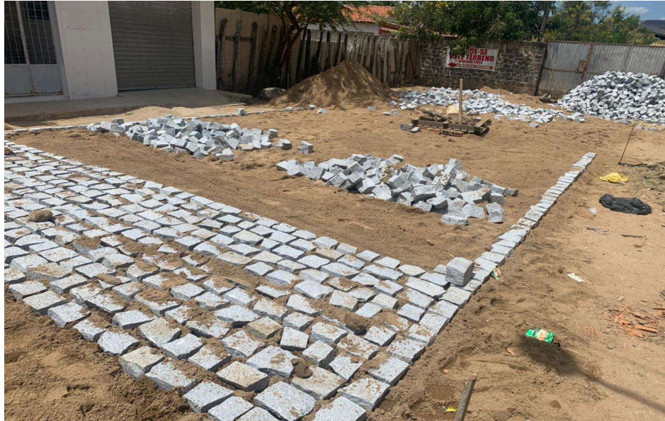
Figura 27: As juntas não se coincidem.
