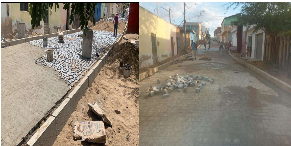
Figura 29: Rejuntamento com argamassa de cimento e areia.
