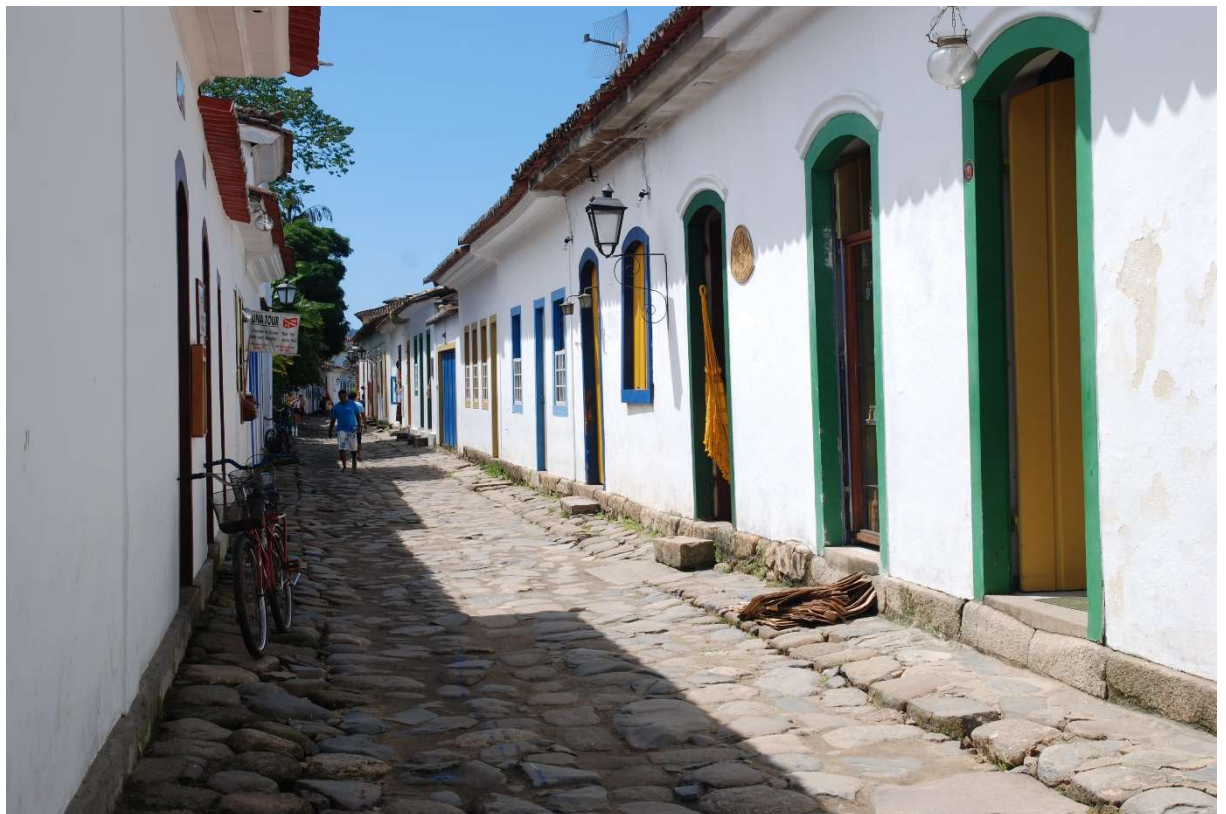
Figura7: Rua de Paraty-RJ: pavimentada com pedras pé-de-moleque, Paraty-RJ.
