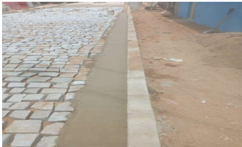
Figura 31: Execução da sarjeta.
