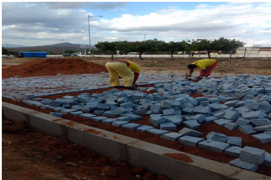
Figura 28 Assentamento das pedras, golpeando com o Martelo.
