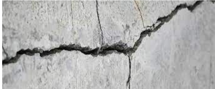
Figura 03: Abertura em edificações
