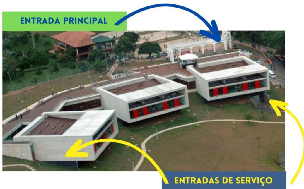
Figura 5 – Entrada de Serviço
