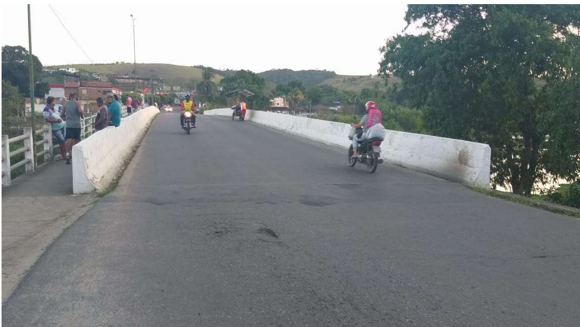
Figura 8: Vista da pista ponte Lucia Paiva
