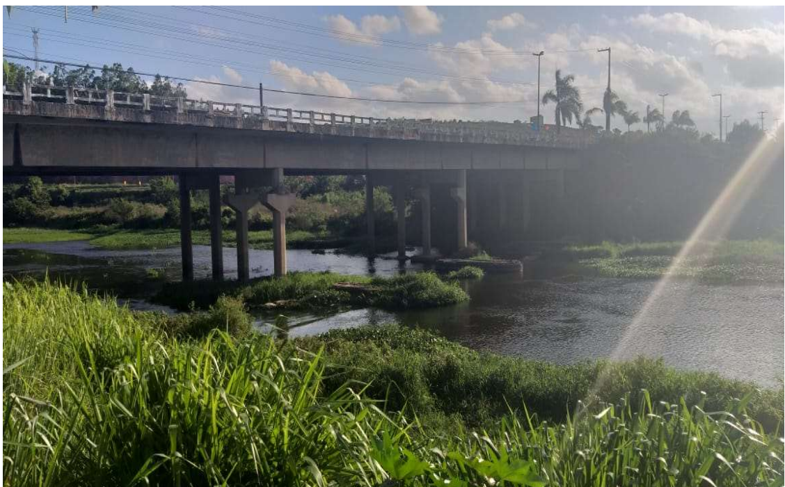
Figura 20: Ponte Japaranduba- vista sobre outro ângulo
