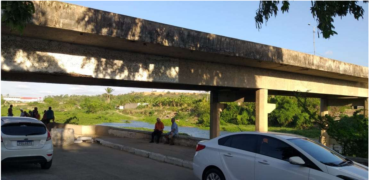
Figura 9: Vista lateral da ponte Lucia Paiva
