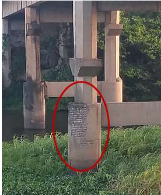
Figura 16: Deslocamento ou Esfoliação
