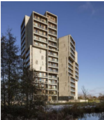
Figura 4 - Visão do edifício a partir do térreo
