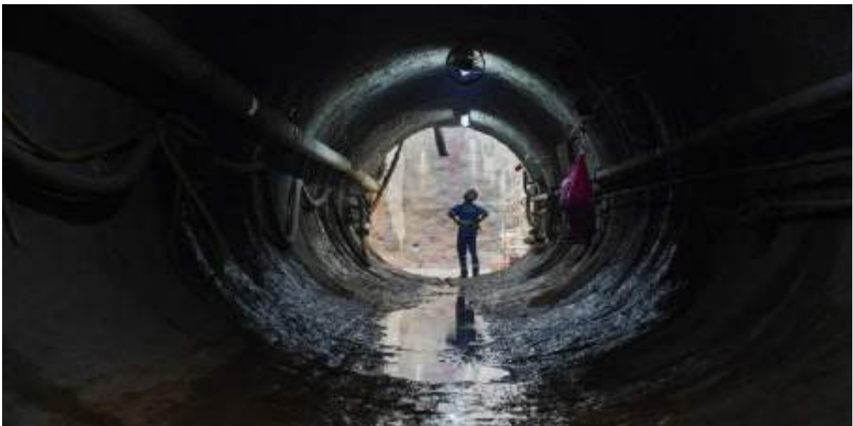
FIGURA 07 - Funcionário trabalha no prolongamento do supertúneo da Sabesp
