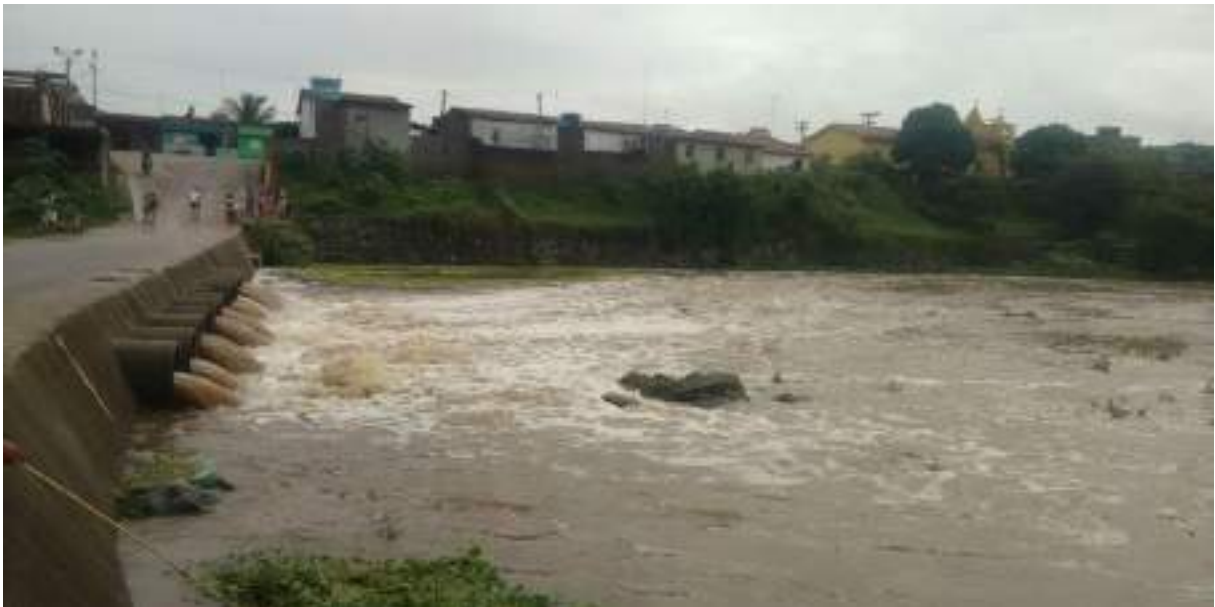
FIGURA 14 - Foto da passagem molhada, em Limoeiro – PE
