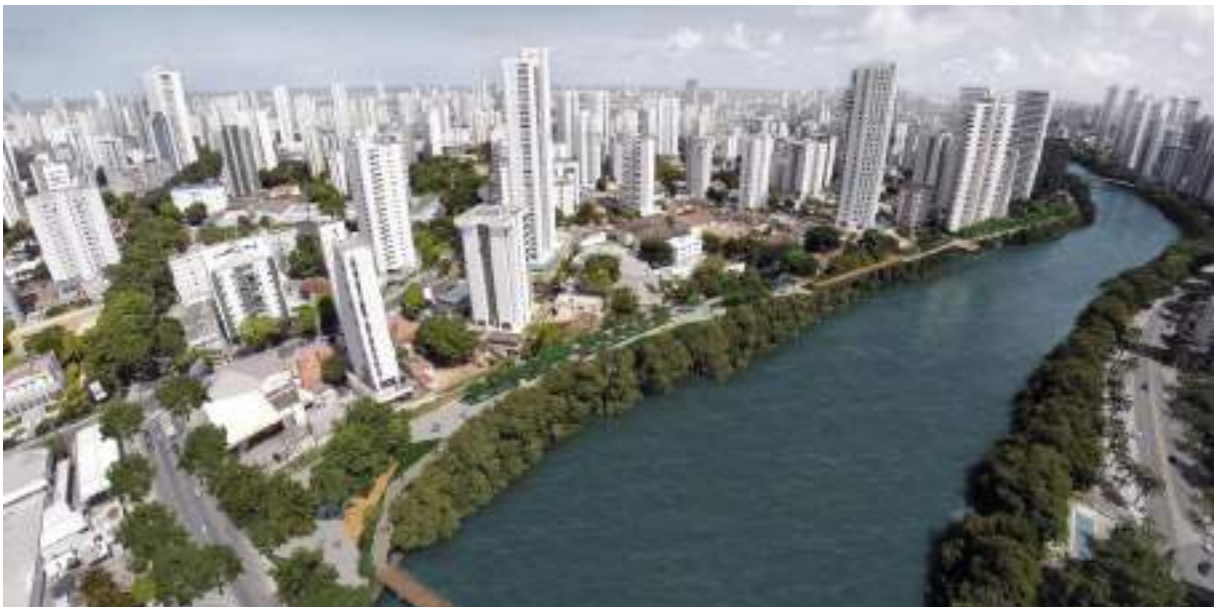
FIGURA 09 - Vista aérea do Projeto Parque Capibaribe no bairro das Graças
