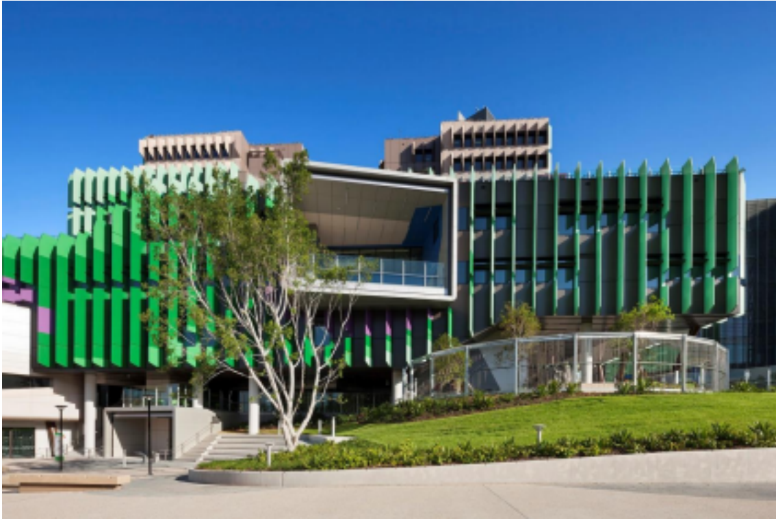
Figura 06- Fachada do Hospital Infantil Lady Cilento
