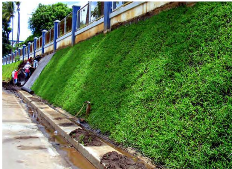
FIGURA 19 – Muro de Arrimo com Vegetação
