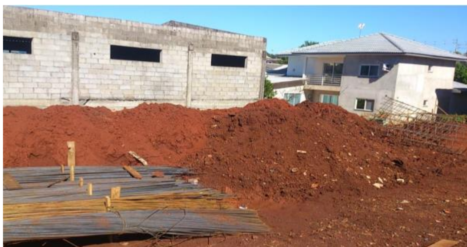
Figura 03 - Disposição do solo removido no canteiro de obras
