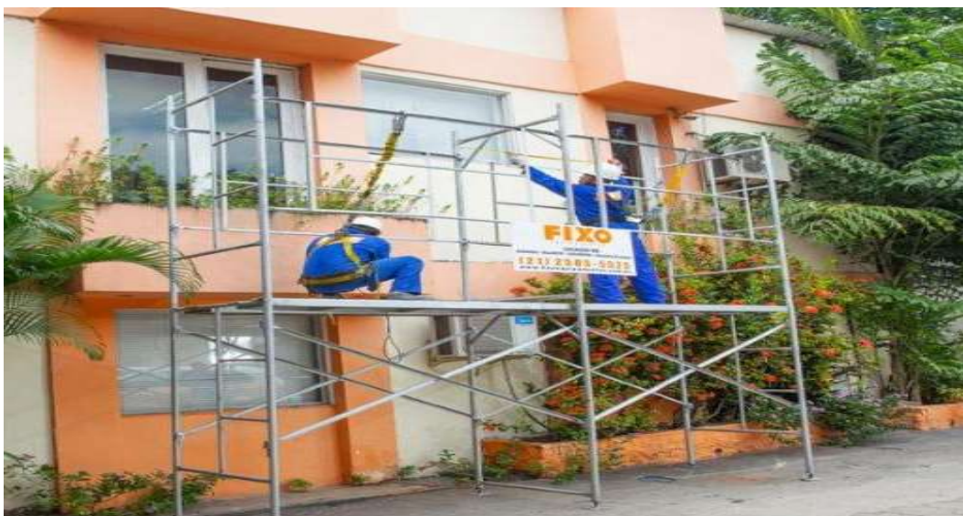
Figura 11: Montagem de andaime para acesso a coberta.
