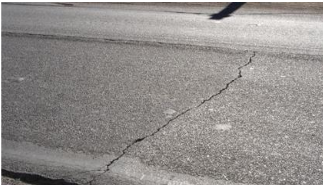
Figura 06 – Trinca transversal
