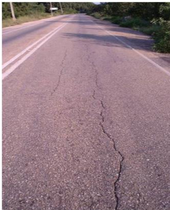
Figura 05 – Trinca longitudinal
