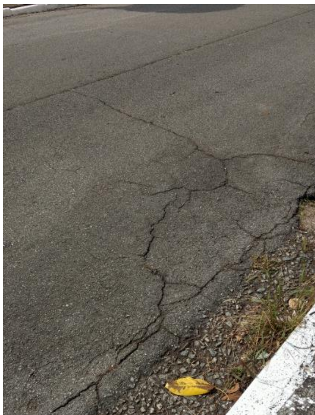
Figura 09 – Trinca de bordo
