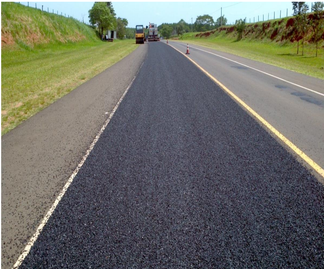
Figura 4 - Pavimento revestido por asfalto borracha
