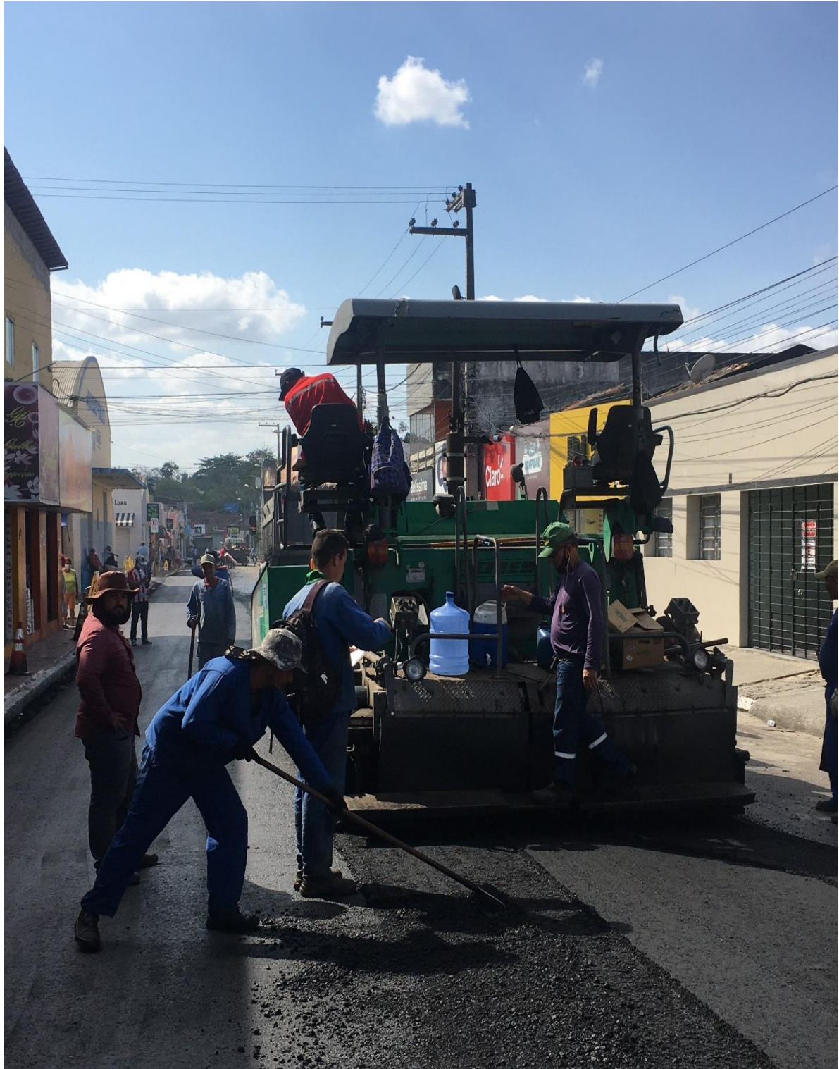
Figura 2 – Recapeamento asfáltico sendo executado com CBUQ
