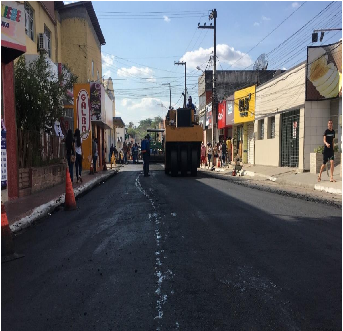
Figura 3 – Pavimento revestido em CAP
