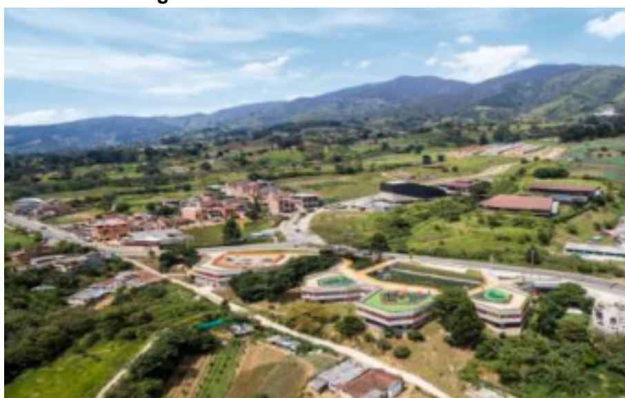
Figura 7 - vista aérea do centro
