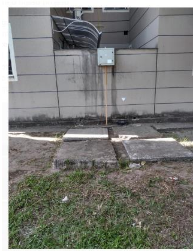
Figura 4 – Fossas sépticas responsáveis por canalizar apenas as fezes.
