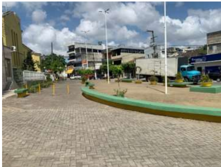
Figura 13 – Praça Manoel Cavalcante atualmente
