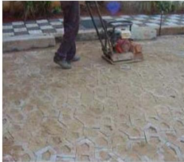
FIGURA 18 – Execução do Pavimento Intertravado nas Ruas de Porto Alegre
