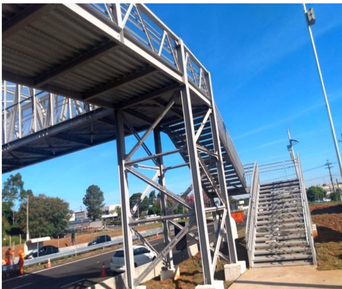
Figura 9 - Passarela em aço
