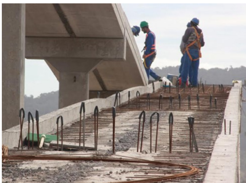
Figura 6 - Execução de passarela em concreto
