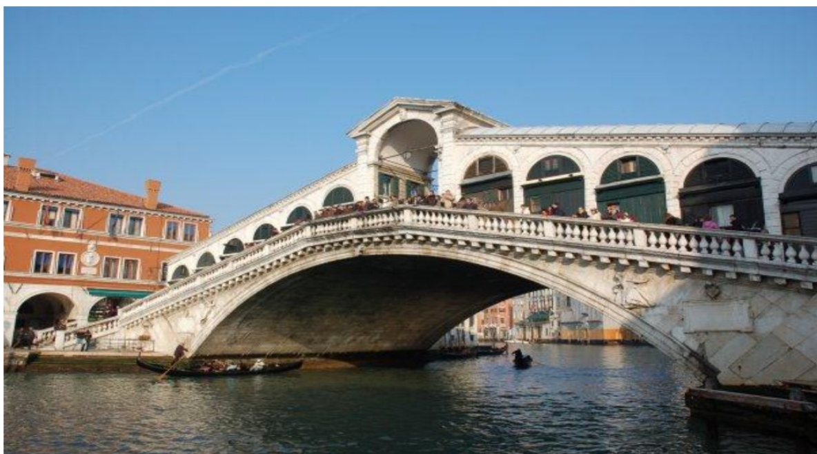
Figura 12 – Passarela em arco
