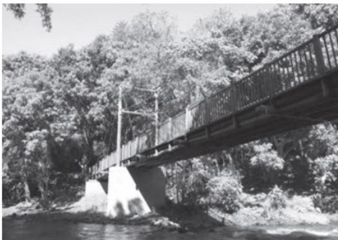
Figura 5 - Passarela em madeira
