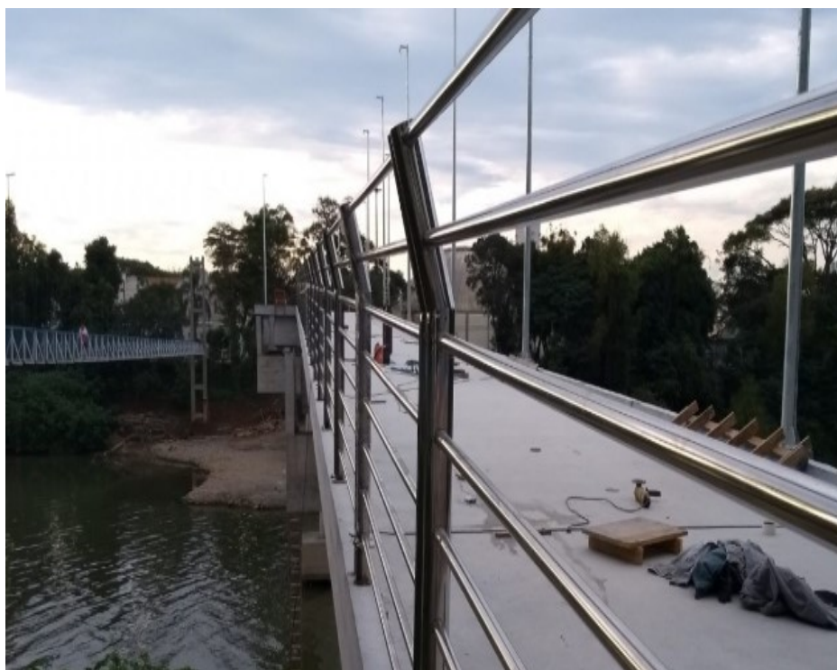
Figura 22 - Acabamento em concreto
