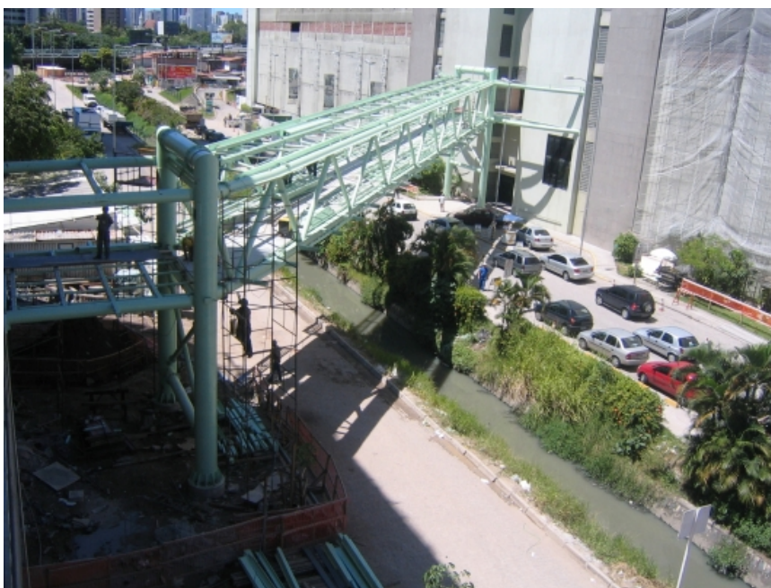
Figura 13 – a) Vista Geral e b) Detalhe construção. Passarela Treliçada, Shopping Plaza – Recife/PE
