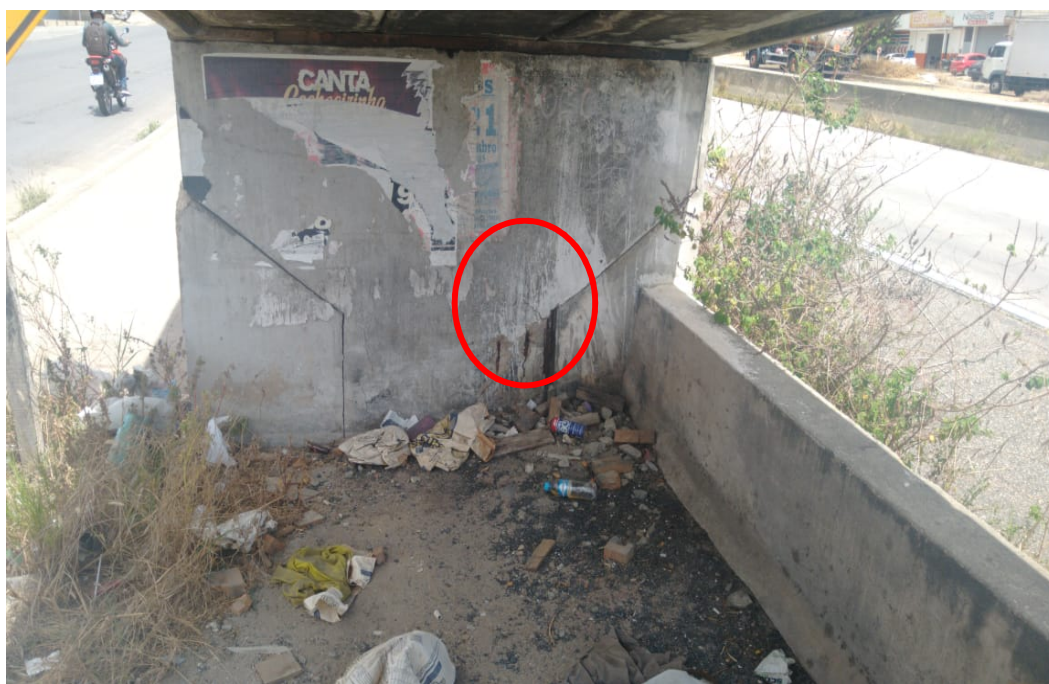
Figura 34- Pilar de apoio da rampa de acesso à passarela
