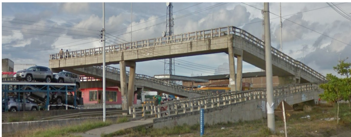
Figura 23 - Vista Frontal e rampas de acesso, sentido interior
