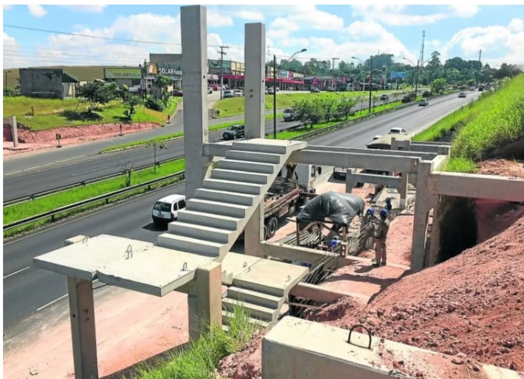
Figura 7 - Execução de passarela em concreto pré-moldado
