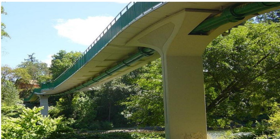
Figura 11 - Passarela sobre o Rio Rogue, Oregon/USA
