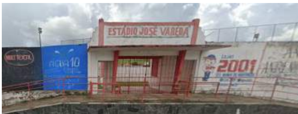
FIGURA 26: Fachada principal do estádio José Vareda
