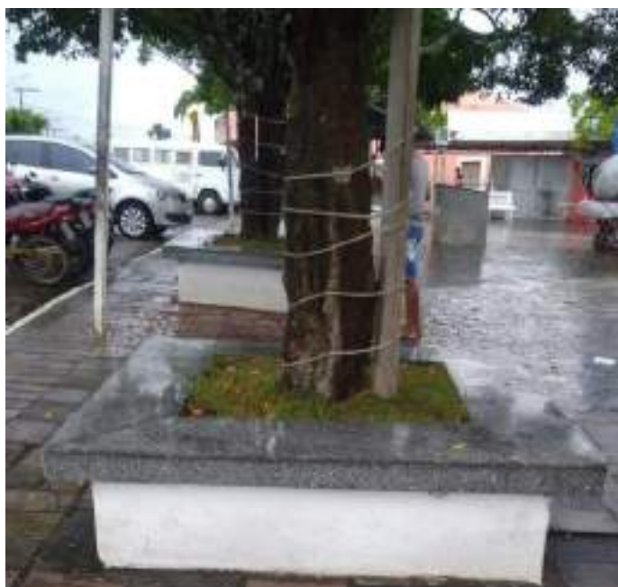
Figura 29 - Banco de alvenaria
