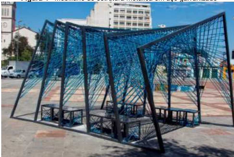
Figura 4 - Mobiliário de estrutura metálica em aço galvanizado
