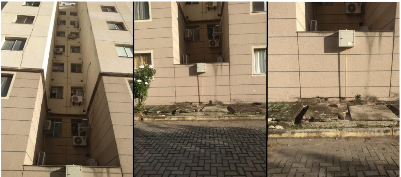
Figura 1 – Condomínio Estação do Sol e alguns de seus sistemas de fossa séptica.
