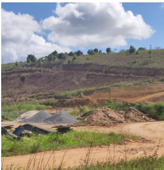
Figura 10: Materiais de construção civil e RCC em canteiro de obras.
