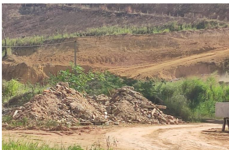
Figura 9: Descarte de resíduos da construção civil e demolição em canteiro de obra.
