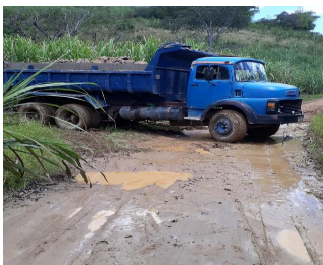
Figura 5: Uso de RCC nas estradas da zona rural do município de Palmares.
