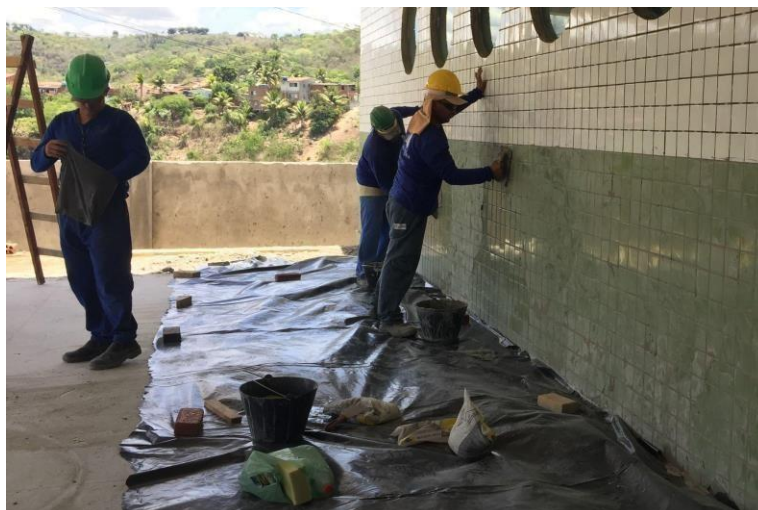
FIGURA 22 - Aplicação de rejunte
