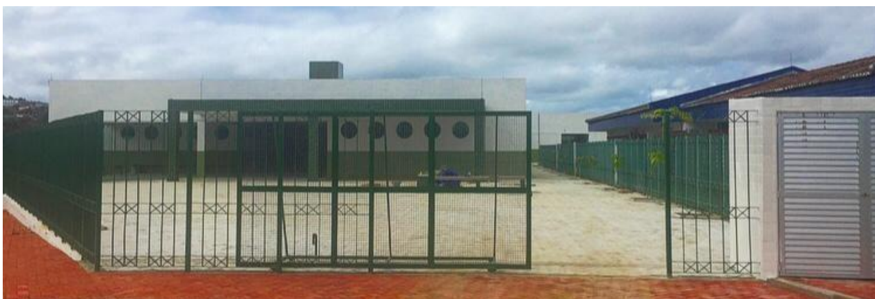
FIGURA 8 - Obra em andamento
