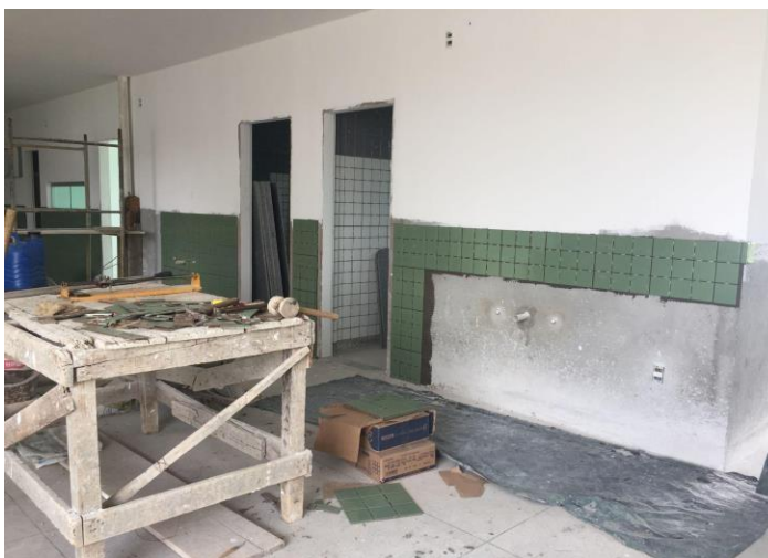
FIGURA 20 - Corte de trinchos
