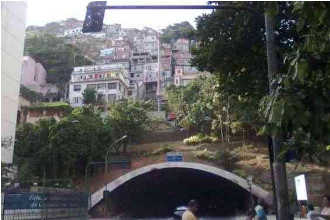
Figura 6. Túnel Sá Freire Alvim. Copacabana. Rio de Janeiro. Copacabana, Rio de Janeiro.
